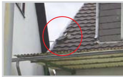
Kaum sichtbar: Lose Dachziegel können für das ganze Dach gefährlich sein.
