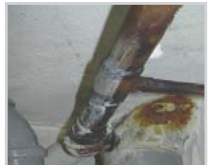
Ob Be- oder Entwässerung: So dürfen Leitungen nicht aussehen.
