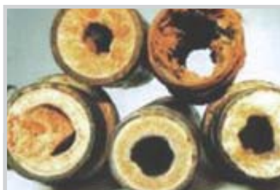
Kalk und Korrosionsablagerungen bieten hervorragende „Nistplätze“ für Legionellen.
